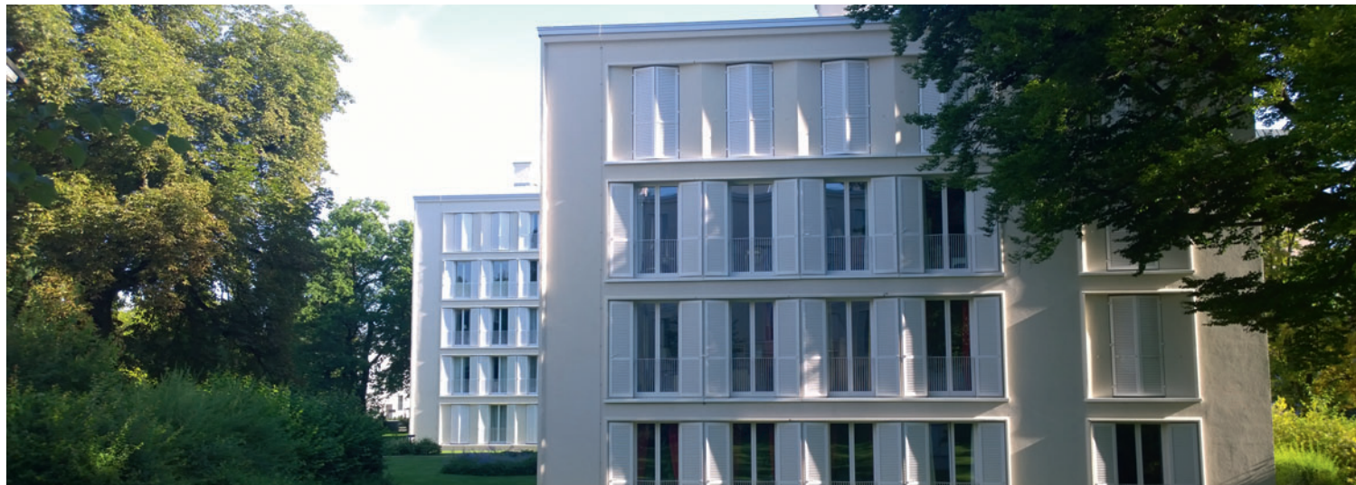
Die Fontavia Parkvillen in Bad Tölz, ein von der Innova Hausverwaltung GmbH verwaltetes Objekt
